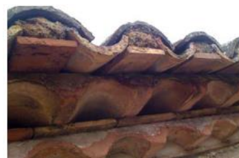
Le surplomb est porté par des chevrons, une corniche ou une génoise. Ici une génoise à deux rangs.
