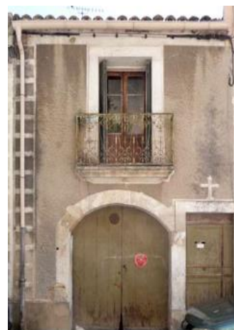
Exemple typique de maison viticole, avec porte charretière, balcon ouvragé, décor d'encadrement des baies plus clair que la façade, décor de chaîne d'angle.
